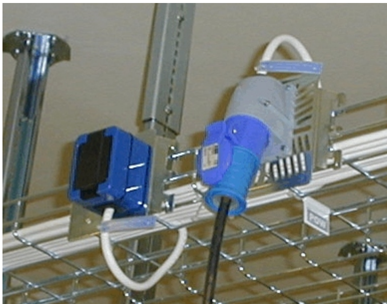
Figur 1: 1-fas uttag av typ Schuko (till vänster) och industriuttagsdon 16 A (till höger)
