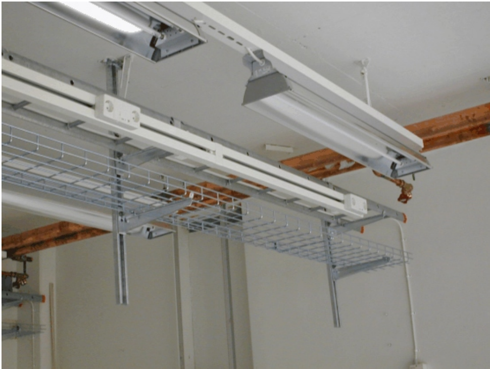
Figur 2: Skensystem ("KB-kanal") med pluggbara uttag
